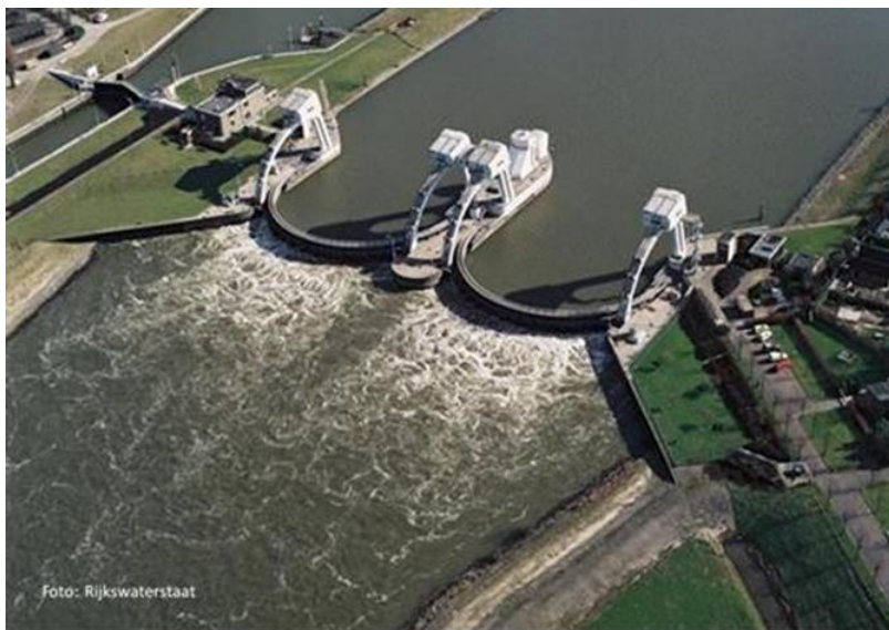
Figuur 5: Stuw in een rivier (Hagestein)
