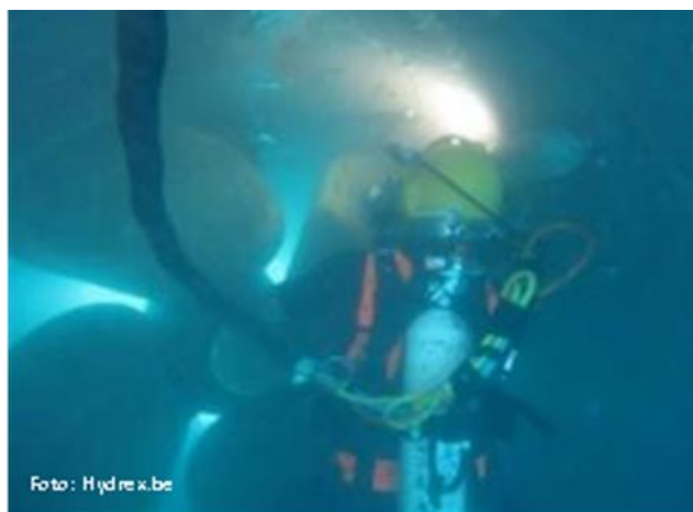
Figuur 6: Duikwerkzaamheden nabij een schroef
