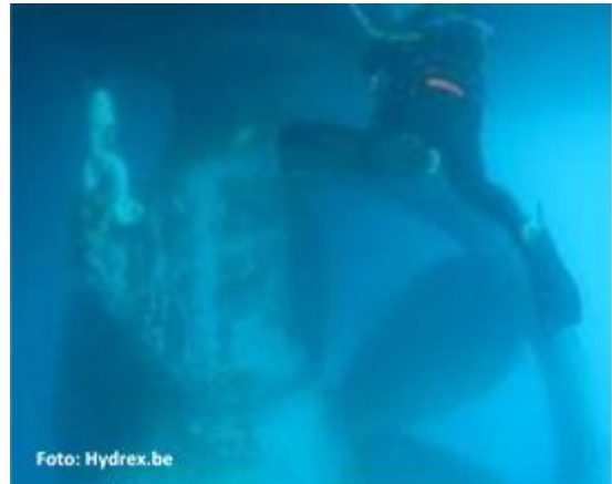
Figuur 20: Duikwerkzaamheden nabij een schroef
