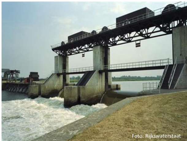
Figuur 3: Stroming als gevolg van verschillende waterstanden (Sambeek)
