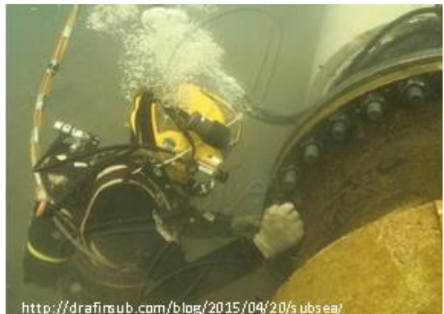
Figuur 1: Duikwerkzaamheden aan leidingen
