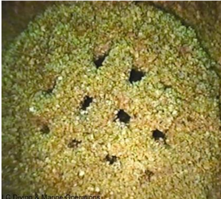
Figuur 22: Dichtgegroeide inlaat
