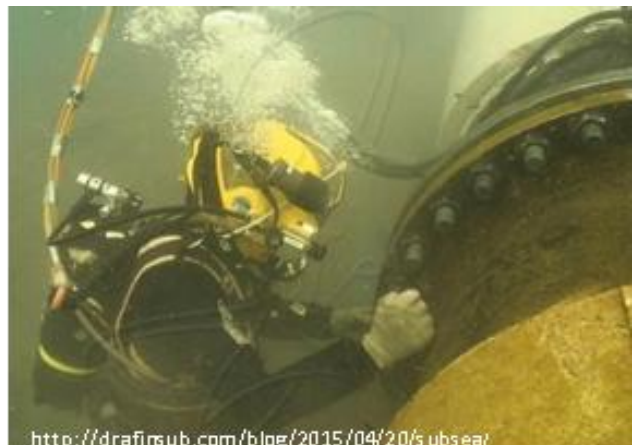
Figuur 1: Duikwerkzaamheden aan leidingen
