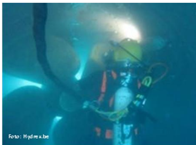
Figuur 6: Duikwerkzaamheden nabij een schroef
