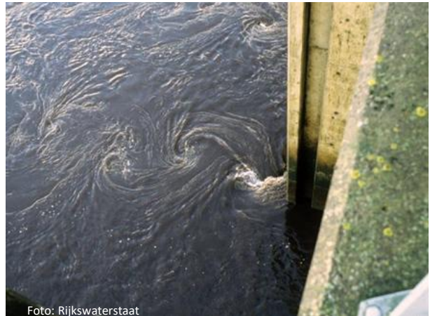
Figuur 4: Aanwijzingen aan de oppervlakte van stroming
