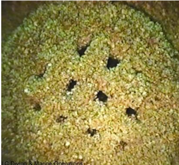
Figuur 22: Dichtgegroeide inlaat
